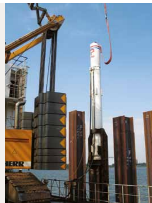
Покрытие многоугольным шаботом профиля L25
